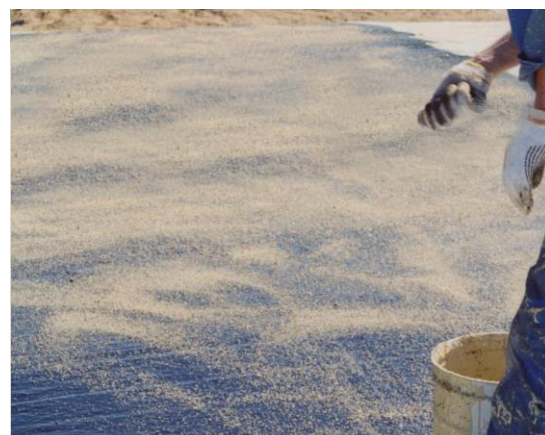
Kvarcni pijesak emitiran na završni sloj
